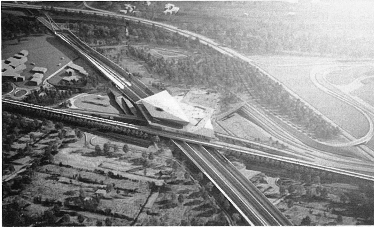
Stato del sito dopo l'installazione dell'opera: L'ASFALTO DIVENTA VERDE PUBBLICO
