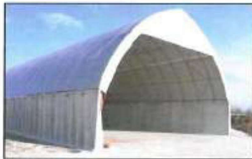
Figura 76 – Silos orizzontale con copertura tipo "tenso-struttura"
