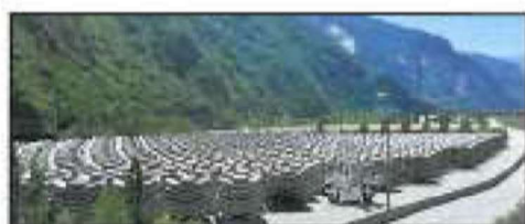
Figura 37 – Stoccaggio dei conci prefabbricati per il cantiere della Galleria di Sicurezza del Frejus (presso St. Etienne de Cuines, Francia) – Movimentazione con carro-ponte su rotaia
