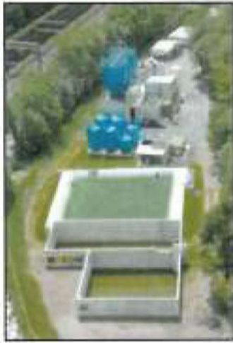
Figura 34 – Cantione AlpTransit (Vigana, Svizzera) – Impianto di trattamento delle acque reflue di cantiere
