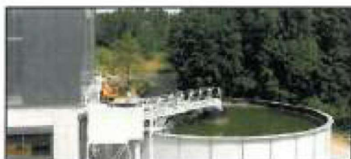
Figura 39 – Impianto di valorizzazione dei materiali di scavo – Particolare dell'impianto di trattamento delle acque
